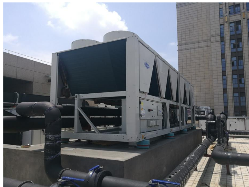
门急诊楼楼顶 1 台风冷热泵 门急诊楼楼顶 1 台风冷热泵
