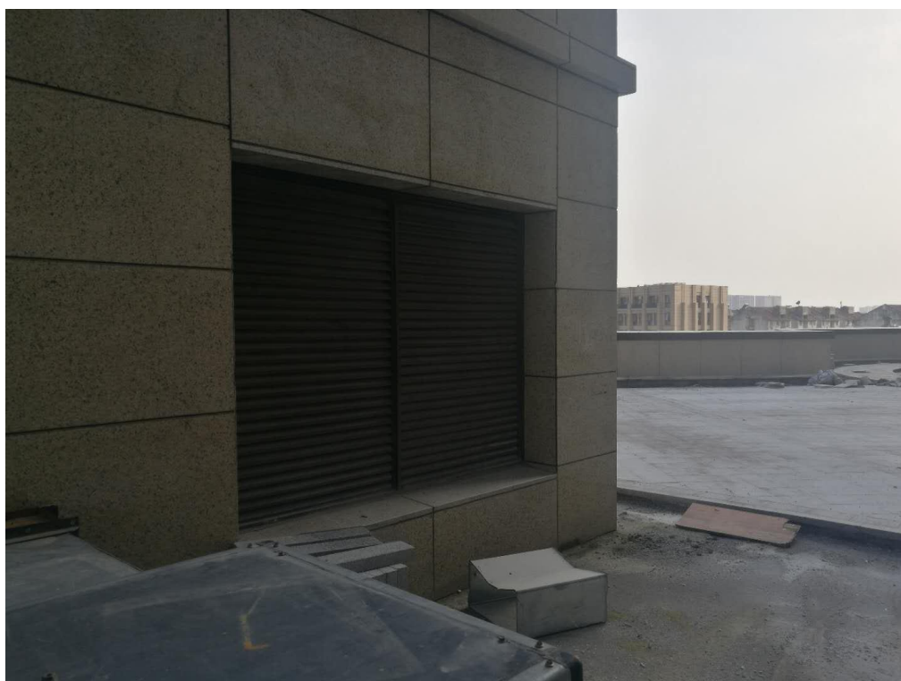
医技楼 P5 排气口
