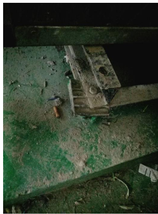
风机设备减振垫
