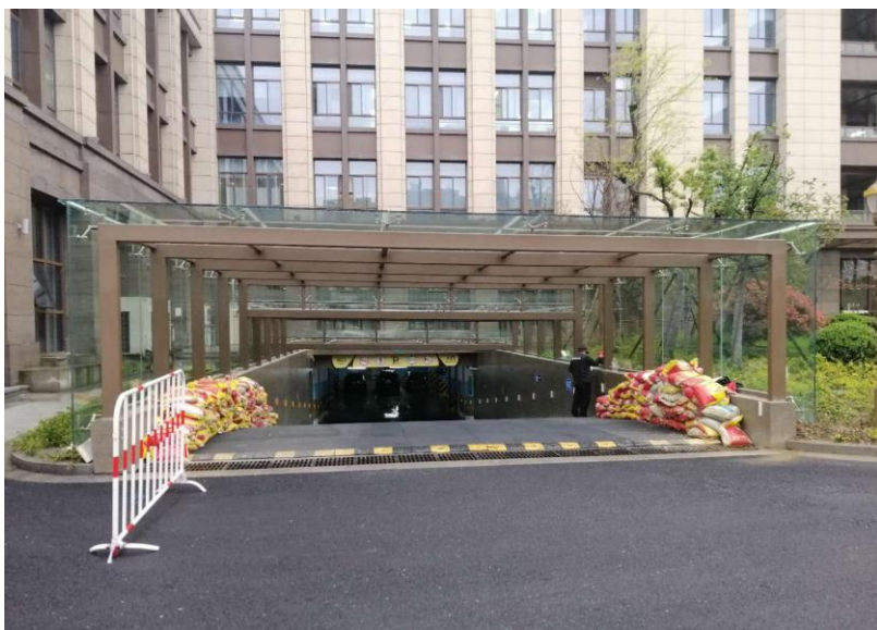
医技 楼东 侧出 入口 隔声 顶棚
