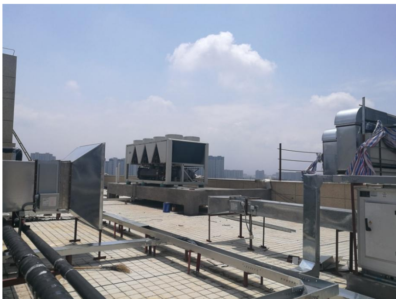
门急诊楼楼顶 1 台风冷热泵 门急诊楼楼顶 1 台风冷热泵
