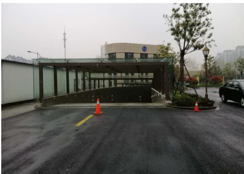
感染 门诊 楼西 侧出 入口 隔声 顶棚
