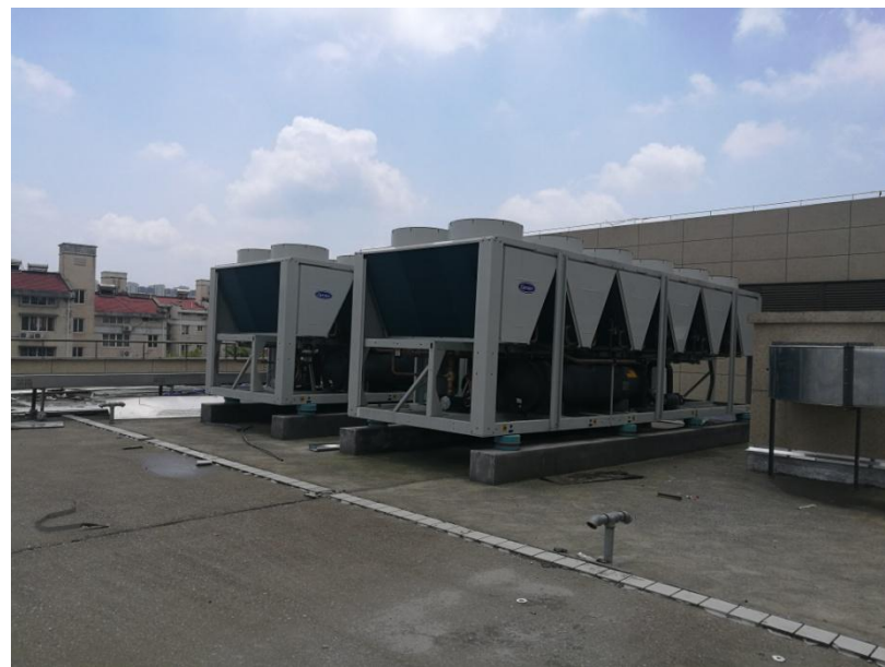
医技楼楼顶 2 台风冷热泵 住院楼南侧地面 1 台风冷热泵
