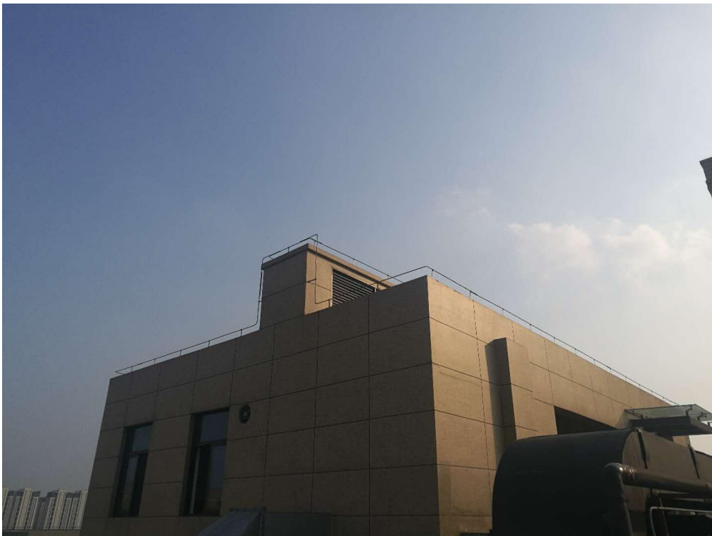
门 急 诊 楼 P3 排 气 口
